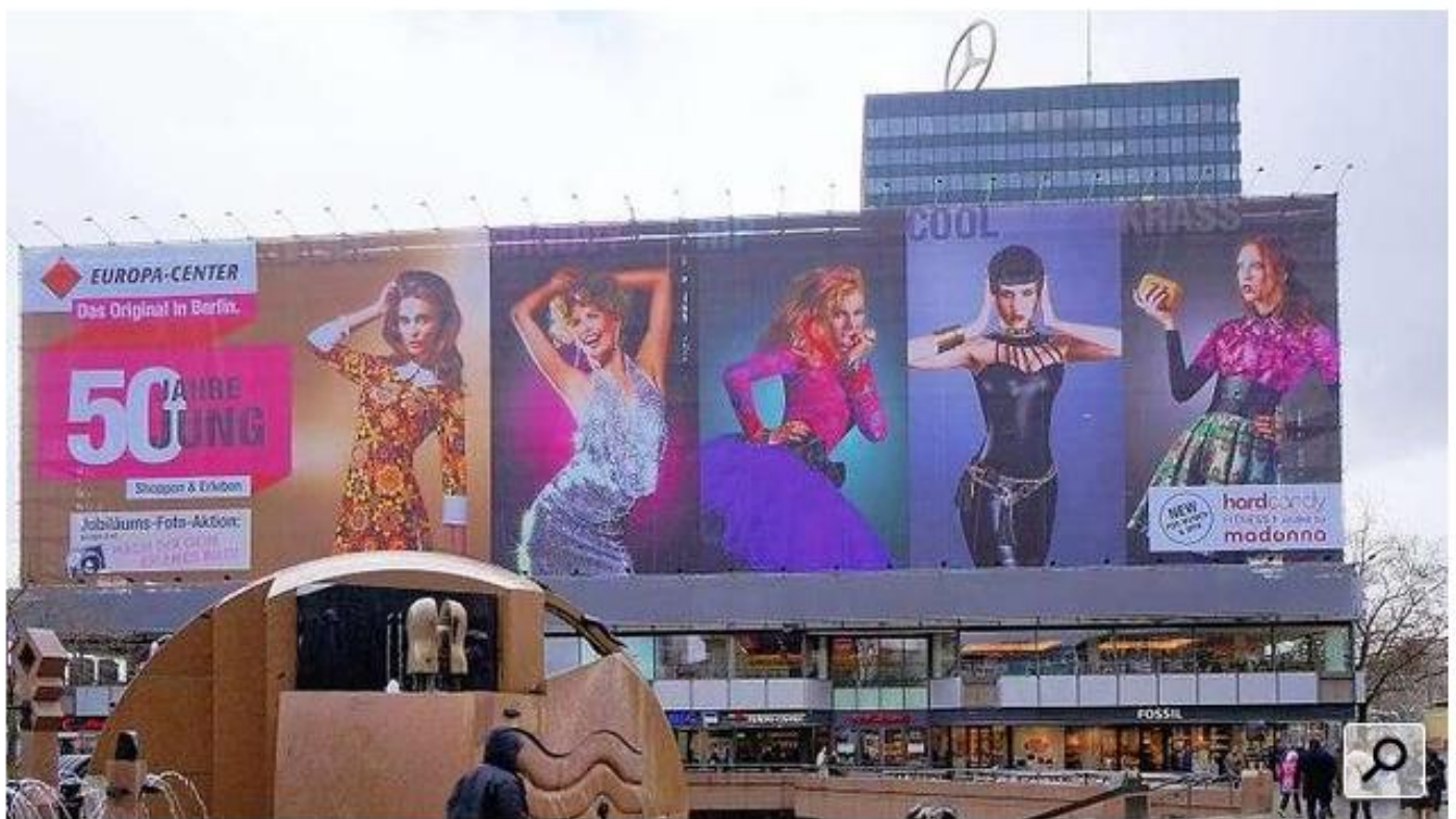
Im Geburtstagskleid. Zum Jubiläum des Europa-Centers gibt es passende Werbung an der Fassade, die gerade renoviert wird. - FOTO: CAY DOBBERKE
